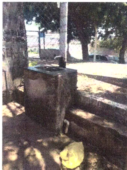
Figura 18 - Tanque a ser demolido
