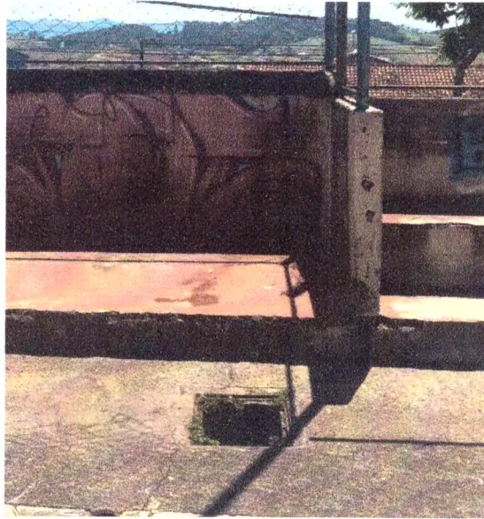
Figura 20 - Caixas pluviais
