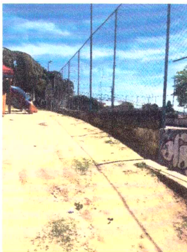
Figura 3 - Reforma das Paredes da Arquibancada
