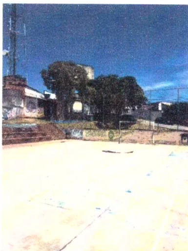
Figura 6 - Piso da Quadra
